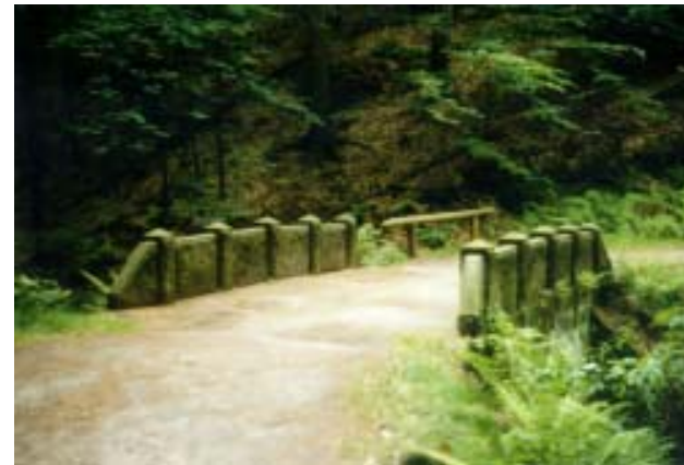
Bild 7: Historische Sandsteinbrücke über den Schindergrabenbach am Eingang zum Halbenweg
